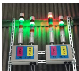
死角になる設備のミラーリングアンダソン
