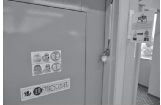
写真6 扉の反対側の人の存在を表示灯で知らせるぶつかり防止システム
